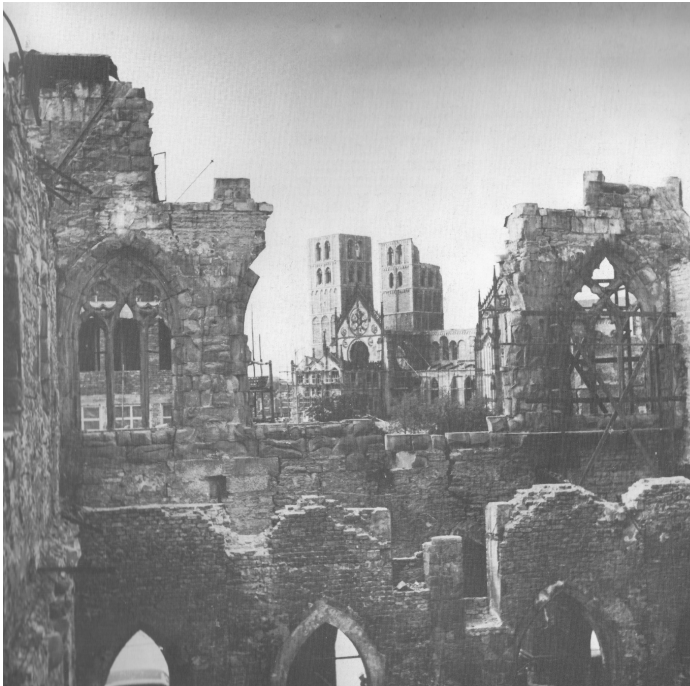
Abb. 8: Zerstörtes Rathaus von Innen, Aufnahme nach Westen, in Höhe des Fußboden-Niveaus des Festsaales, rechts und links das Maßwerk der beiden äußeren Fenster, im Vordergrund das Ziegelmauerwerk der Westwand der Bürgerhalle, und dahinter den Naturstein des später vorgesetzten Schaugiebels
