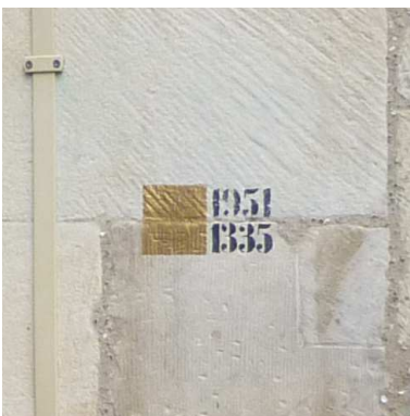
Abb. 25: Markierung einer Baufuge zwischen Alt- und Wiederaufbau
